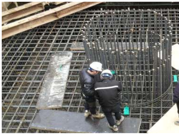
P1(상주방향) 기초 안전점검 전경
