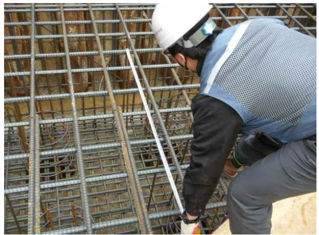
P1(영천방향) 기초 상면 횡방향철근
