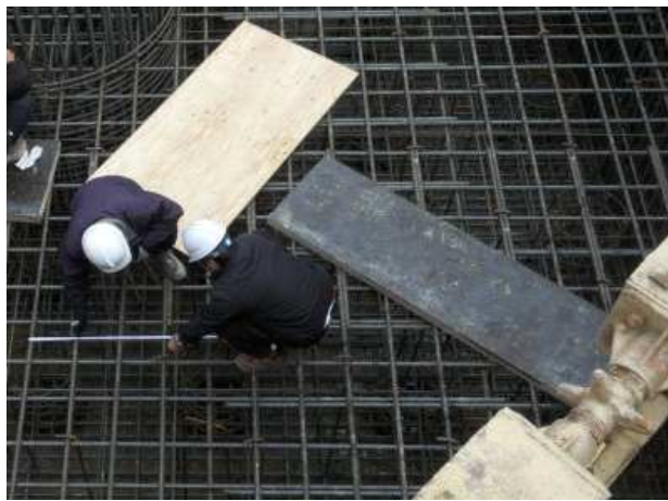
P1(영천방향) 기초 안전점검 전경
